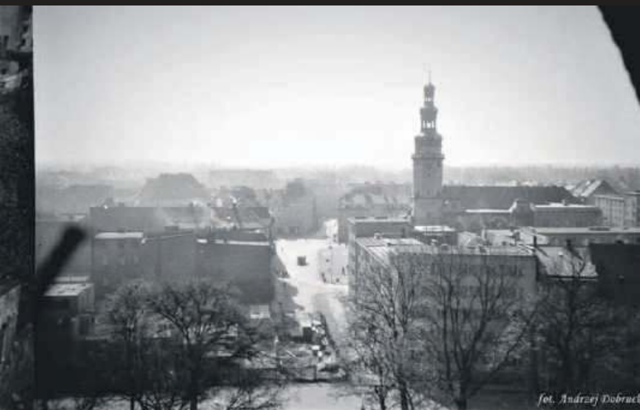
Zdjęcie wykonał w 1967 Andrzej Dobrucki z wieży ciśnień. Na pierwszym planie widzimy budynek przy Placu Zamkowym nr 5-8 w budowie
