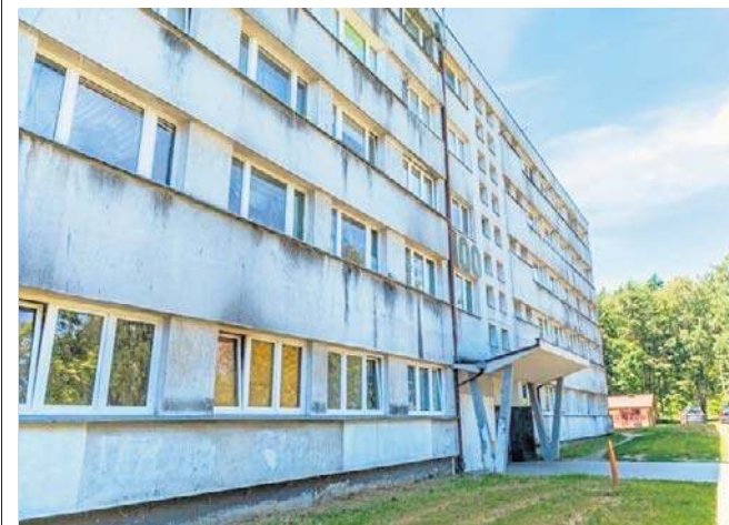
Samorząd miasta przeprowadzi kompleksową modernizację bloku nr 100, 100A i 100B w Bełchatowie
