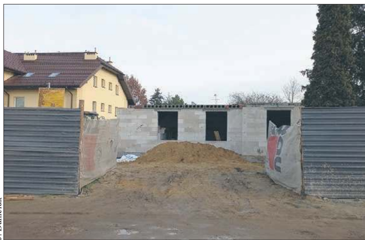
Trwa budowa nowego bloku przy ul. Miodowej 27
