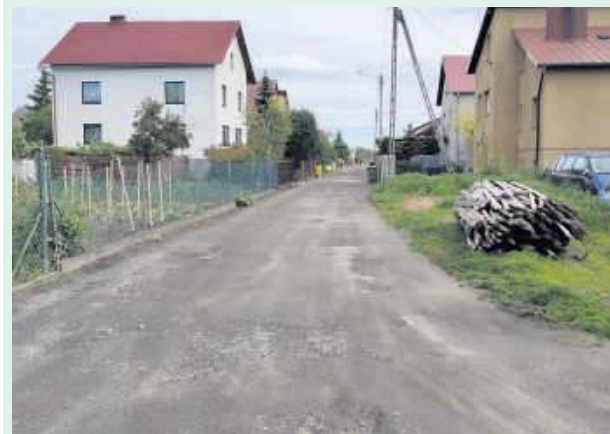
Na ul. Różanej w Borowie zostanie położony asfalt i zrobiony chodnik
