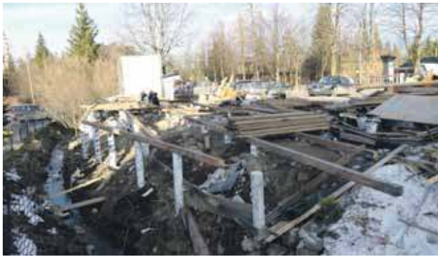
Halny wybitnie pomógł w rozbiorze samowolnie ustawionych pod Wielką Krokwią kramów, ale nowe już rosną na betonowych palach.
