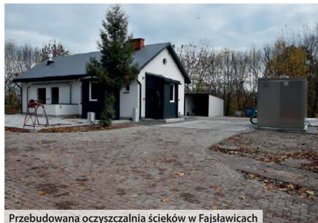
Przebudowana oczyszczalnia ścieków w Fajstowie
