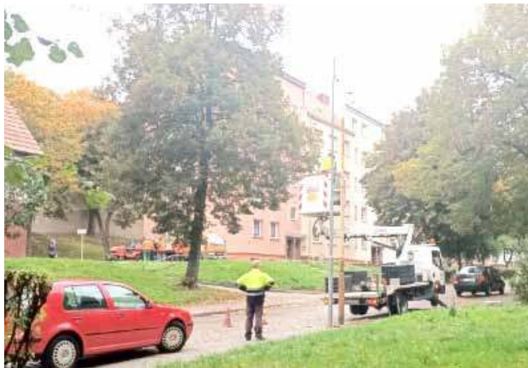
Wymiana skorodowanego słupa na Płatnerzy
