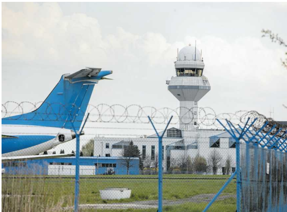
• Wieża kontroli lotów na lotnisku im. Fryderyka Chopina w Warszawie
