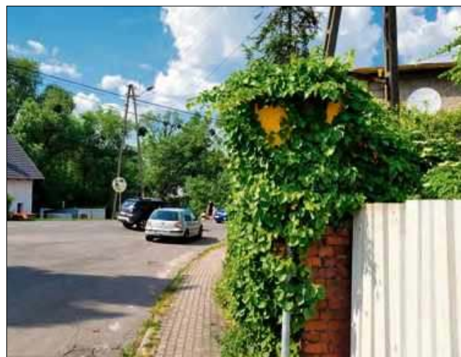
Porośnięty znak drogowy w Żywocicach przy podporządkowanej drodze prowadzącej do ulicy Krapkowickiej.
