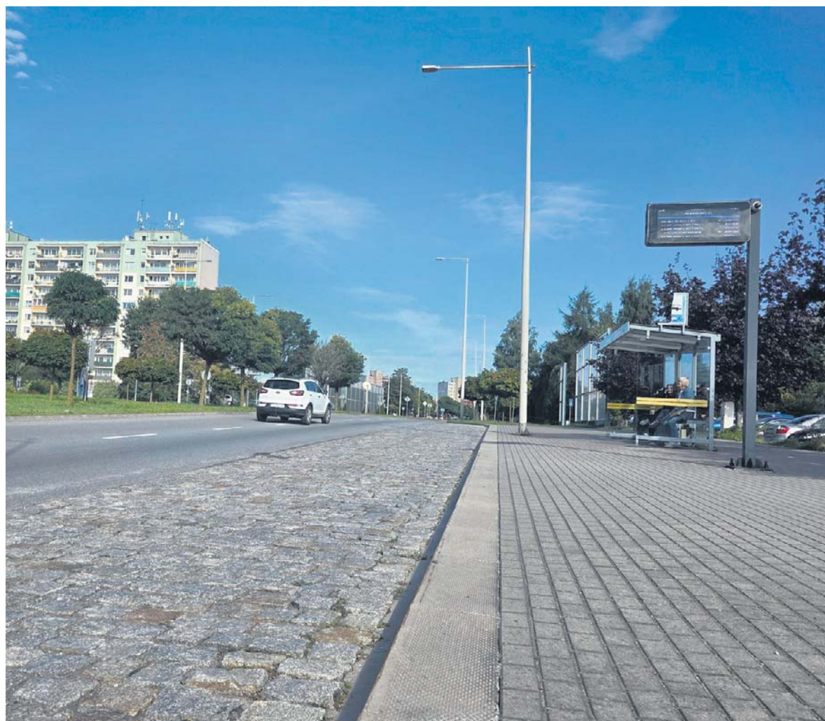
Jednym z przystanków,, które przejdą modernizację będzie przystanek „Urząd Skarbowy” przy ul. 11 Listopada w Słupsku
