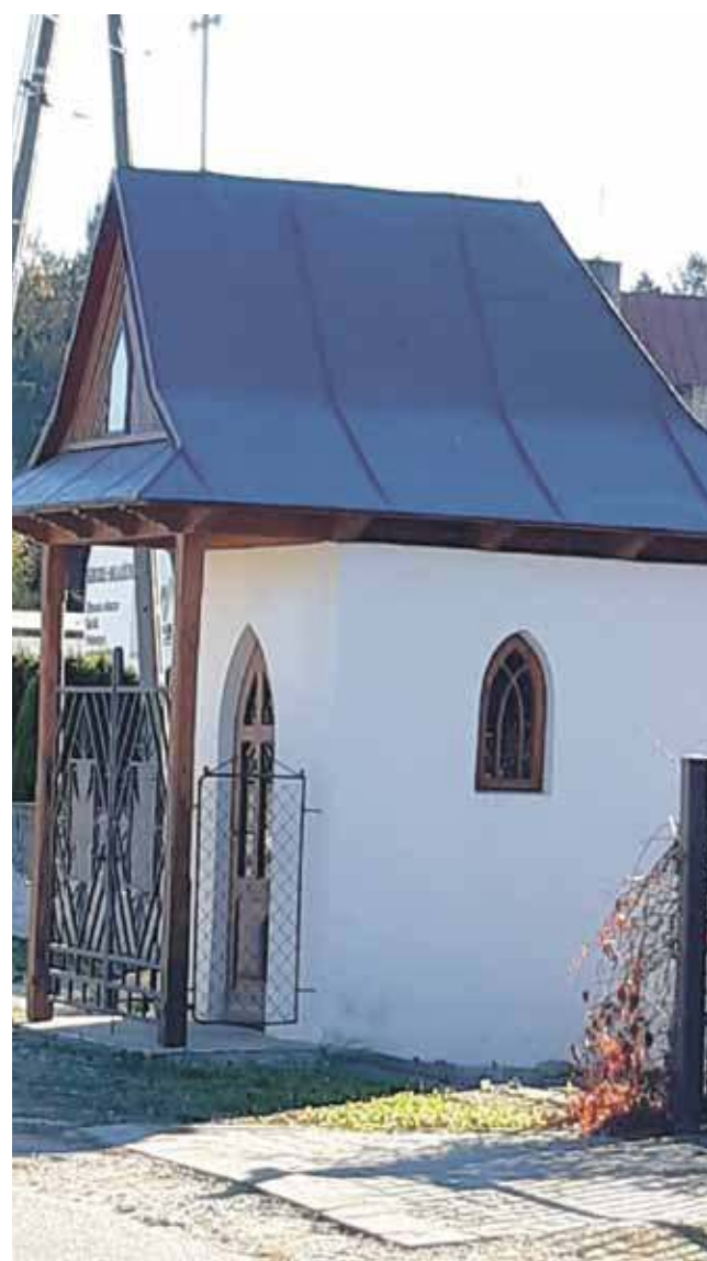
Dach zostanie wyremontowany na wiosnę w ramach pięcioletniej gwarancji.
