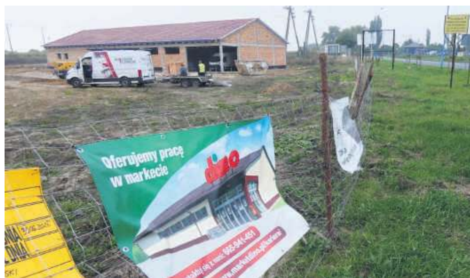
Budowa sklepu wielkopowierzchniowego rozpoczęła się 1 września tego roku
