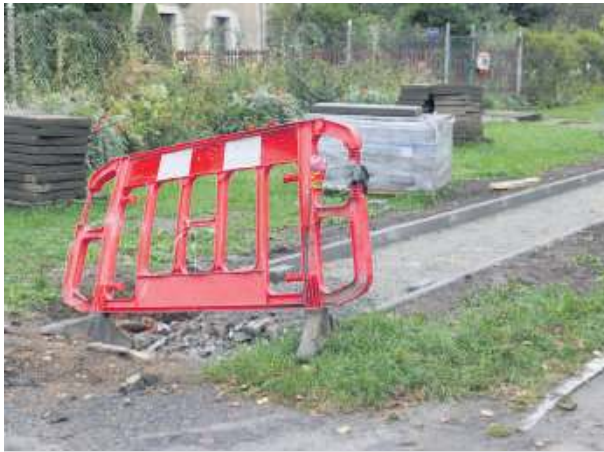
W Szczawinie przy drodze powiatowej trwa remont chodnika
