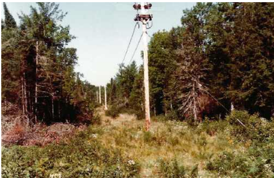
Rysunek 13. Część 23-kilometrowego ramienia anteny ELF w lesie nad jeziorem Clam Lake w stanie Wisconsin. Źródło: www.navy-radio.com/commsta-elf.htm
