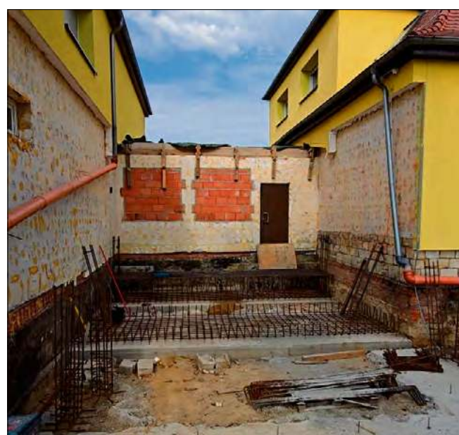
W Steblowie powstaje nowa sala zajęciowa, a szkoła zyska również nowy system ogrzewania.
