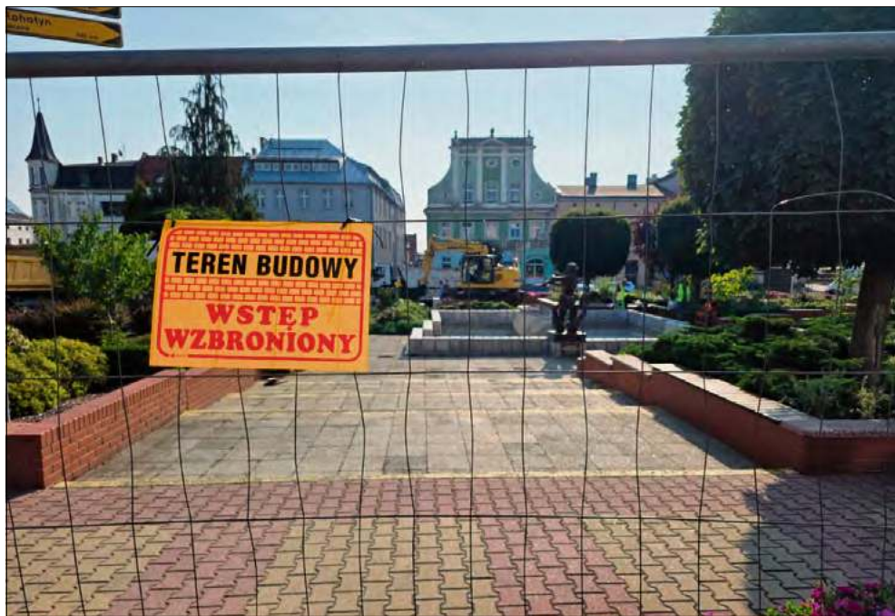
Plac budowy został ogrodzony, a wykonawca rozpoczął pierwsze prace rozbiórkowe.
