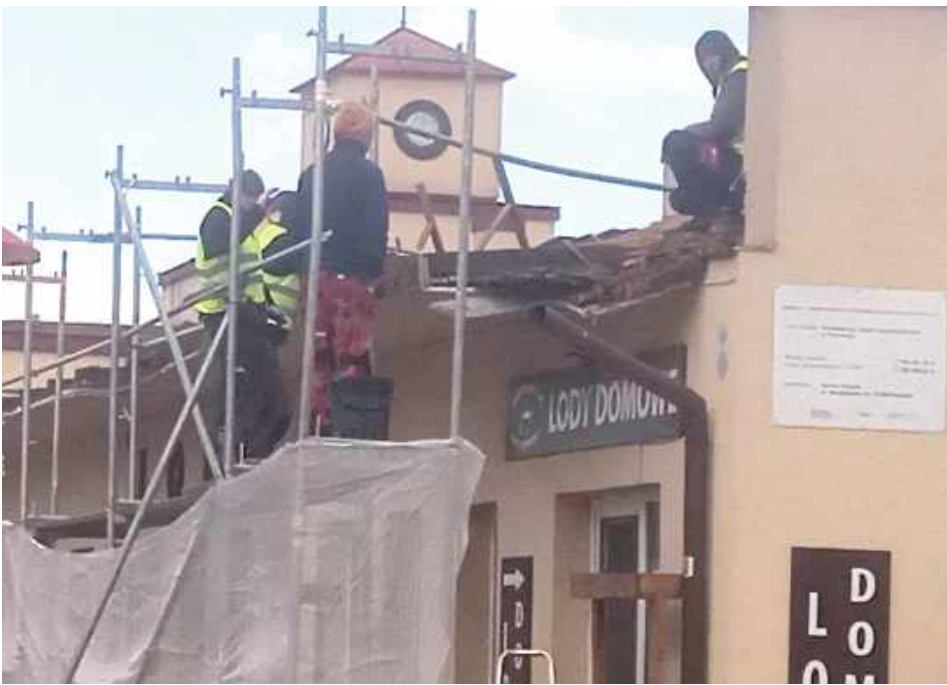
GR Pierwsze prace ruszyły przed Wielkanocą
