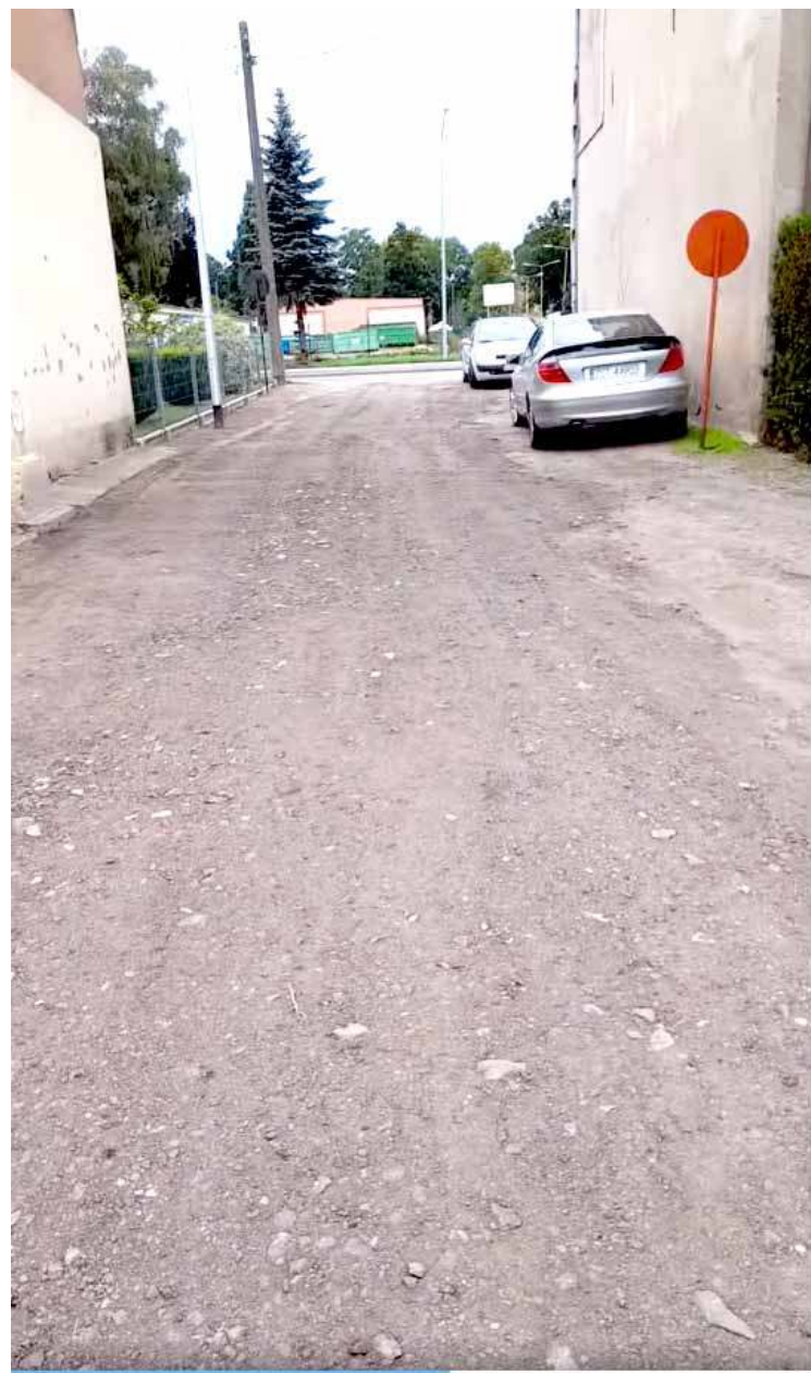
Droga dojazdowa na ulicy Spokojnej zdaniem mieszkańców powinna mieć gładką nawierzchnię asfaltową, a nie jak do tej pory rozplanowany żwir
