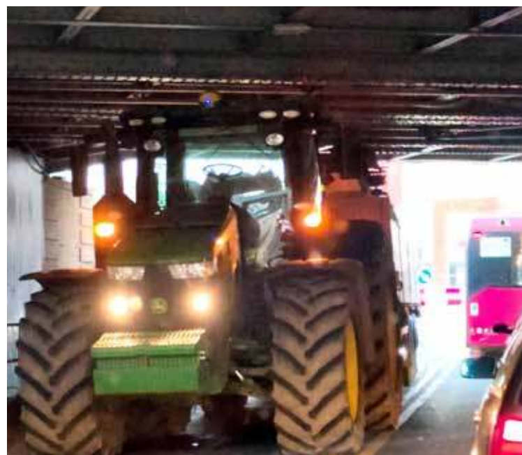
Kierowca ciągnika nie zwrócił uwagi na znak drogowy wiszący na wiadukcie co skutkowało tym, że ciągnik zaklinował się pod wiaduktem. Foto. Stoją!Stargard
