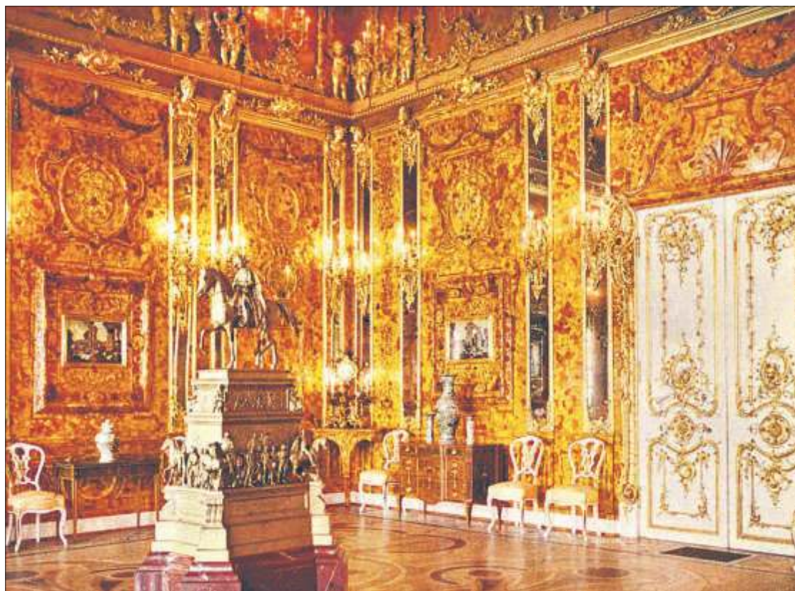
Oryginalna Bursztynowa Komnata – zdjęcie z 1917 r.
