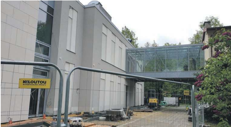
Salę gimnastyczną z budynkiem liceum w Krzeszowicach łączy przeszklona przewiązka
