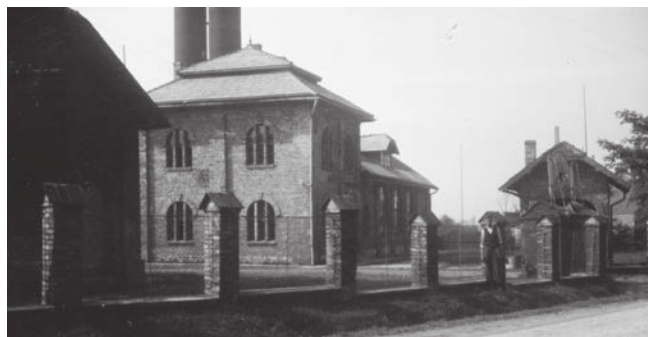
Budynki dawnej gazowni przy ul. Dąbrowskiego w Trzebini, czerwiec 1942r. Źródło: Archiwum Państwowe w Katowicach, sygn. 12/1089/559”
