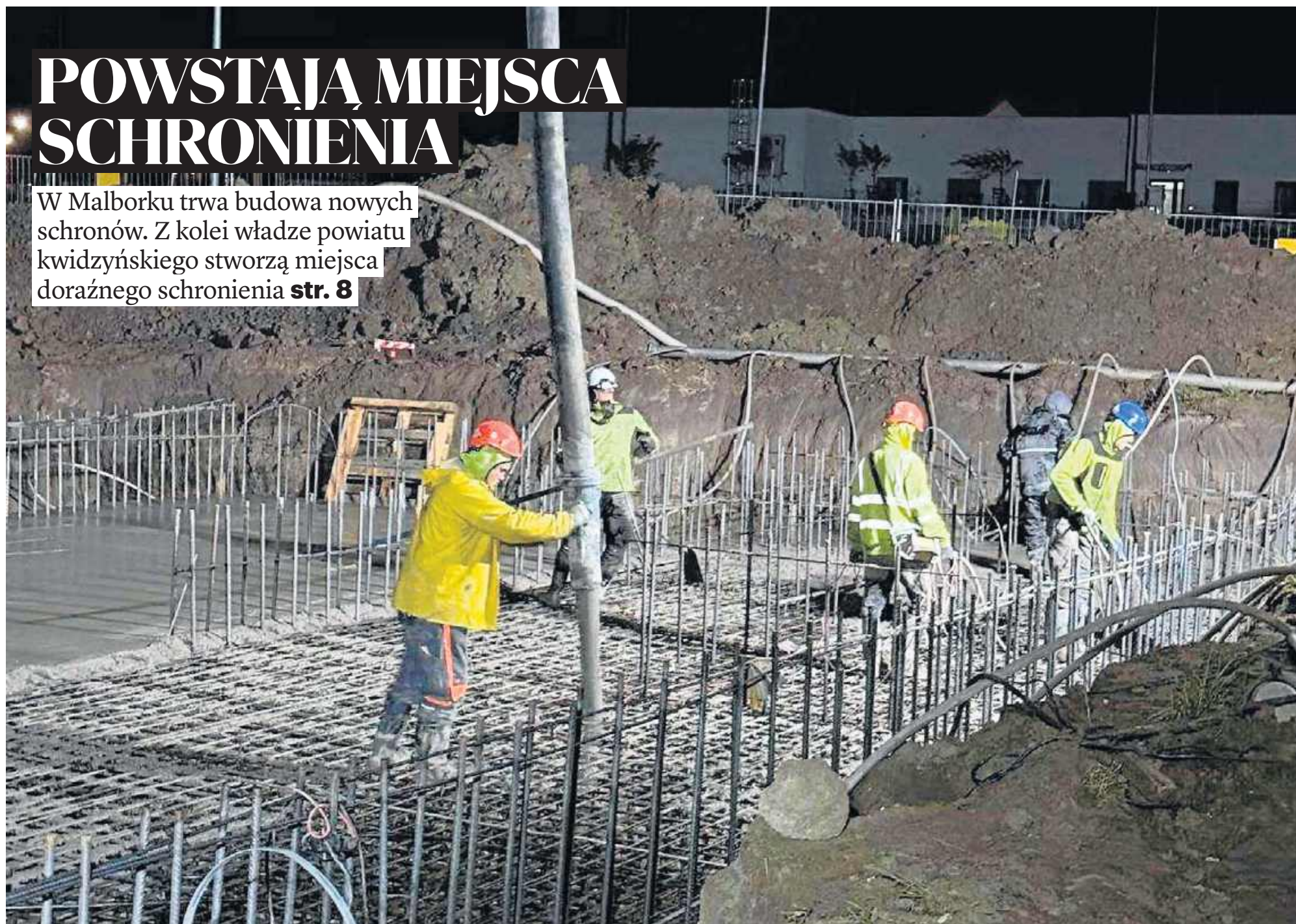
FOT. WAL-MAT/BUDOWA SCHRONU NA TERENIE PSP MALBORK
