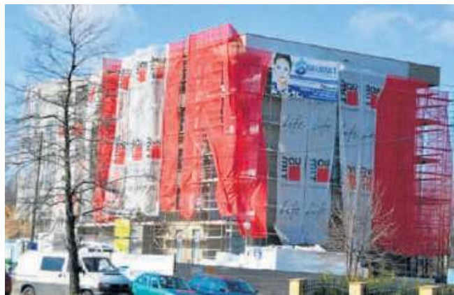
W pierwszym budowanym właśnie bloku przy ulicy Warsztatowej pozostały jeszcze do sprzedaży dwa mieszkania.
