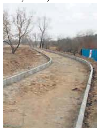
Nad Pilicą powstaje dalsza część ścieżki rowerowej.
