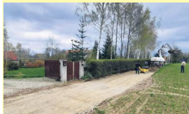
Jako pierwszy remontowany jest odcinek drogi gminnej w Błotnicy. Fot. UG Kondratowice
