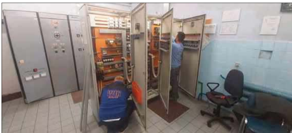
Prace trwają, ale stacja już działa.
