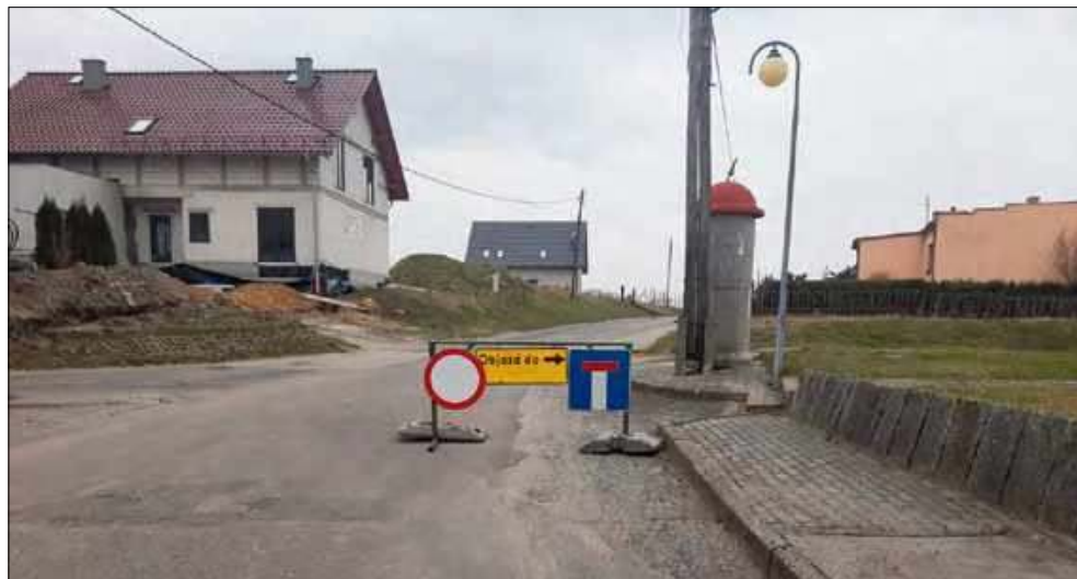
W Oleszce postępują prace związane z budową kanalizacji sanitarnej.
