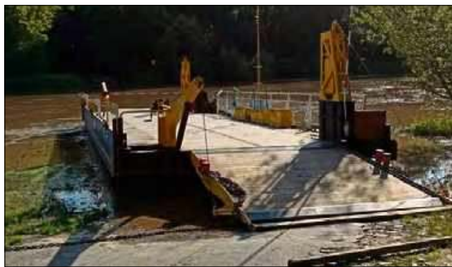
Teren wokół promu w Zdzieszowicach przejdzie gruntowną rewitalizację.
