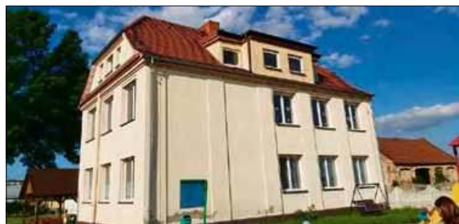
Tak wyglądał budynek przed rozpoczęciem prac.
