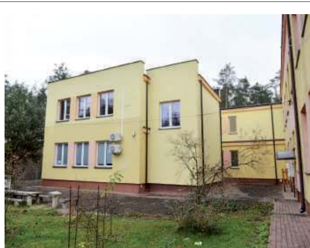
Tak wygląda szkoła po zakończonej rozbudowie
