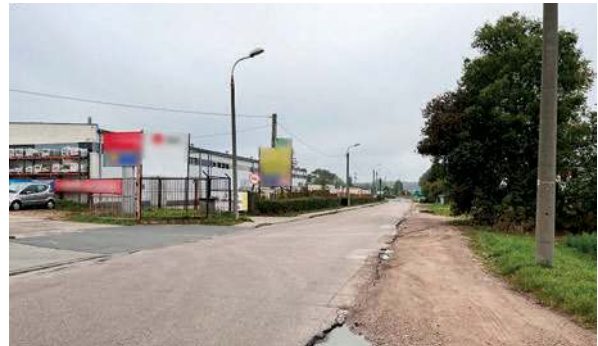
Ulica Śmiecińska przed remontem
