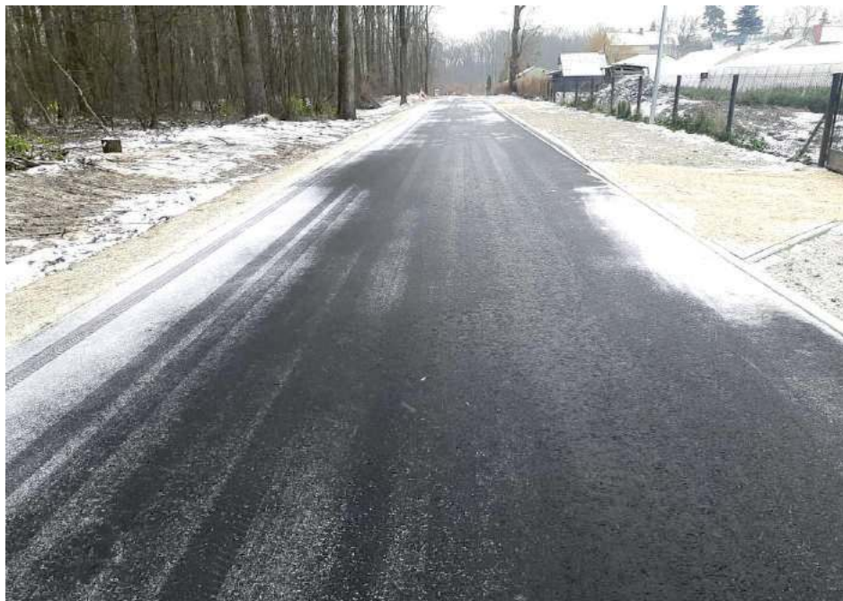
Dziury, kałuże czy błoto to już przeszłość. Teraz mieszkańcy wsi będą mogli bezpiecznie poruszać się po nowym odcinku
