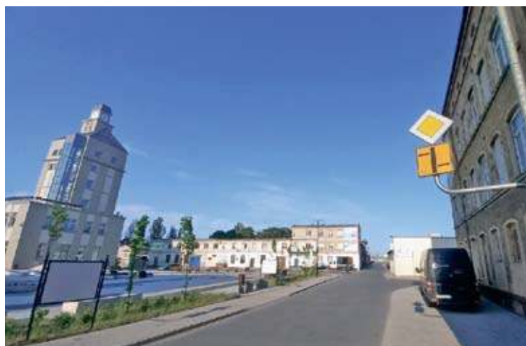
Teren dawnej fabryki przeszedł metamorfozę. Ale to nie koniec inwestowania w tamtym miejscu
