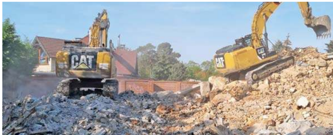
Prace porządkowo-budowlane rozpoczęły się już kilkanaście dni temu (fot. UM Nowa Sól)
