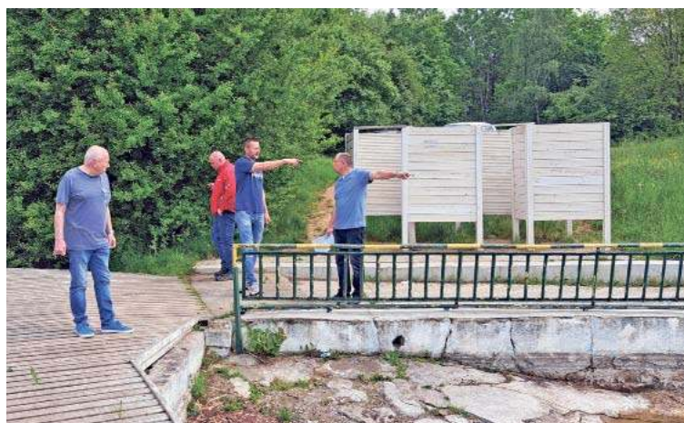
Prace już trwają (fot. UM Nowe Miasteczko)
