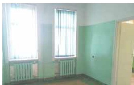
Sala chorych przed remontem
