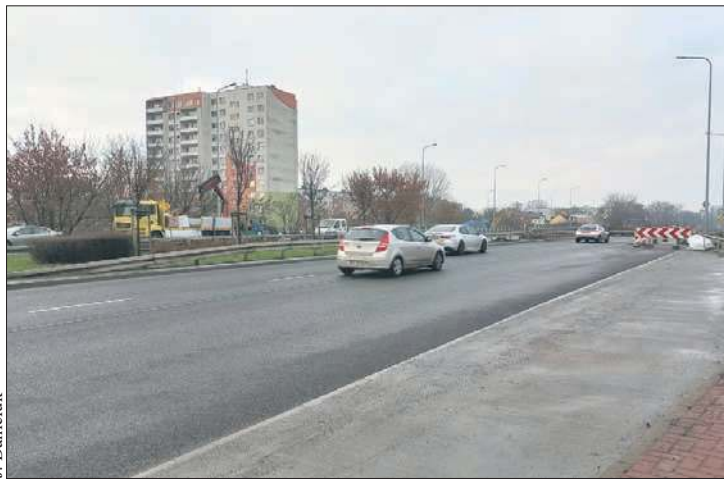
Przed Bożym Narodzeniem na al. Piłsudskiego trwały ostatnie prace
