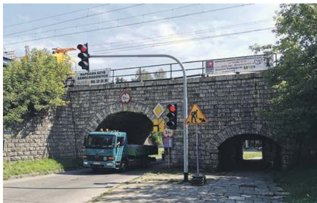
Wiadukt nad ul. Sienną
