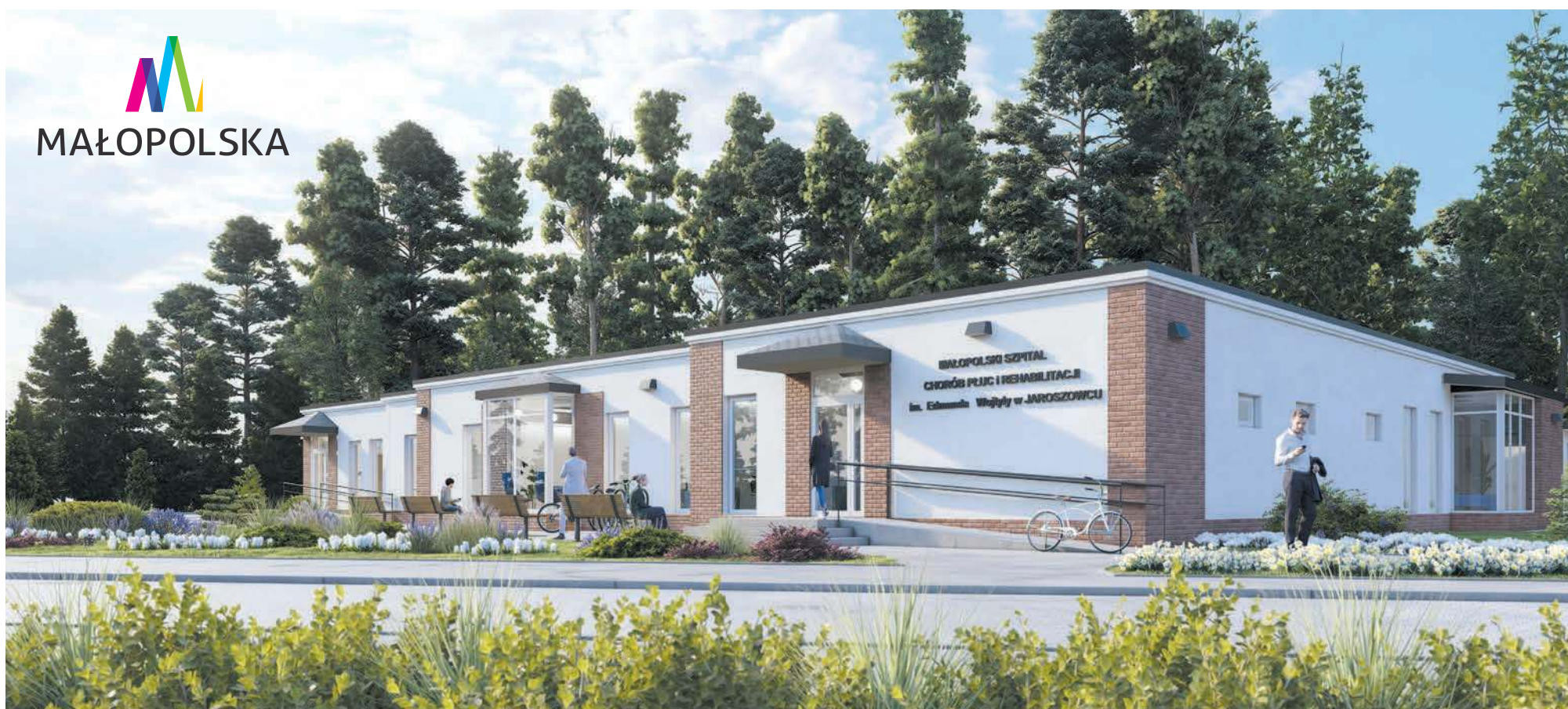
Szpital Chorób Płuc i Rehabilitacji im. Edmunda Wojtyły w Jaroszewcu
