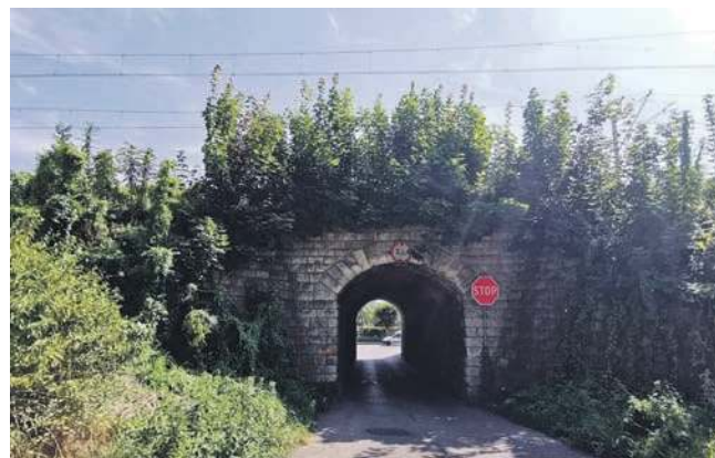
Wiadukt nad ul. Krasickiego
