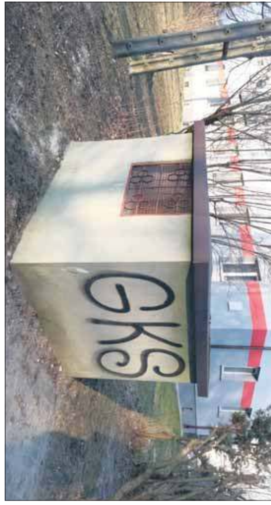
Szybik wentylacyjny schronu - Osiedle Stale (fot. J. Sawiak)
