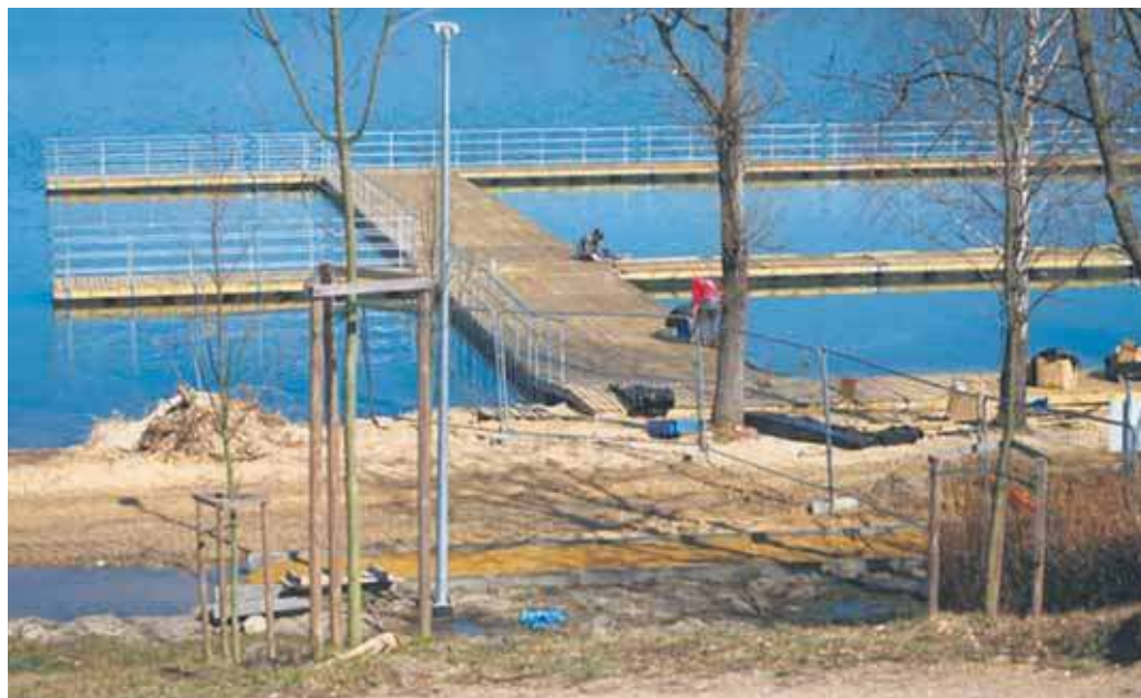
Ostatnie prace nad kładkami
