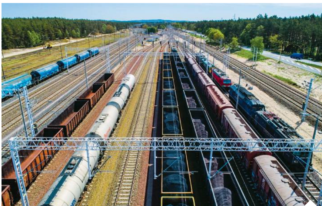
Dzięki wpisaniu korytarza Konstancja–Gdańsk do sieci TEN-T przedsięwzięcia związane z tym projektem będą mogły uzyskać unijne dofinansowanie | fot. PKP PLK S.A./d
