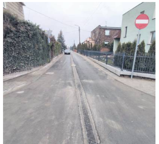
Remont ul. Żwirki i Wigury trwał długo, ale kilka dni temu droga została oddana do użytku
