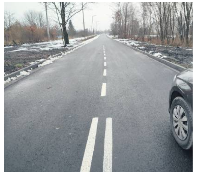
Kiedyś w miejscu nowej ulicy Rubinowej była gruntowa, kręta ścieżka, biegnąca pomiędzy krzakami i ruinami budynków
