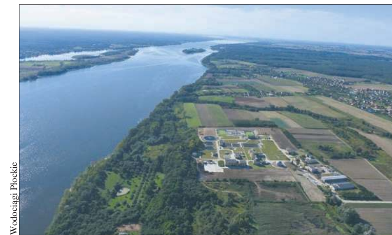
Wodociągi Płockie zaplanowały kolejne prace modernizacyjne w oczyszczalni ścieków w Maszewie.
