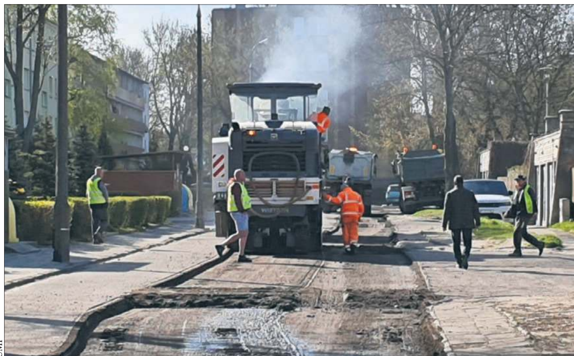
Rozpoczęła się przebudowa pierwszej części ulicy Kredytowej
