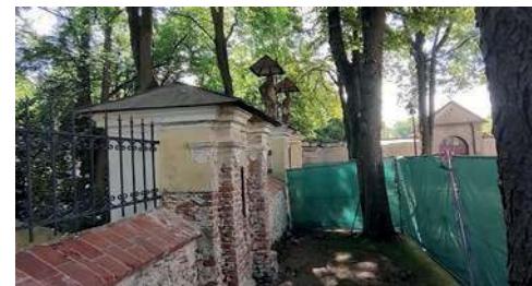
Remont fragmentu muru otaczającego klasztor w Alwerni
