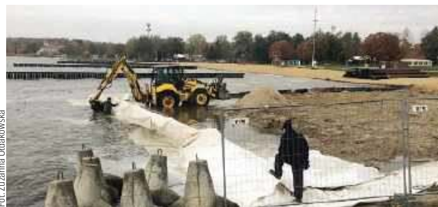
Prace przy molo trwają od początku września
