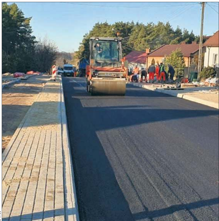
Prace trwają od jesieni ubiegłego roku
