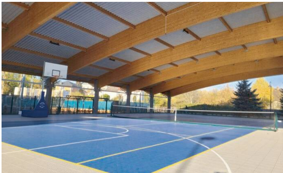
Boisko wielofunkcyjne z nową nawierzchnią
