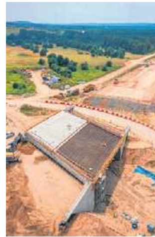
Trwa budowa obwodnic Zawiercia w ciągu DK78
