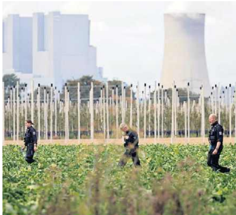
We wtorek niemieckie służby odnotowały próbę sabotażu sieci energetycznej w Bergheim na zachodzie kraju
