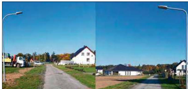
W Dobrej zamontowano nowe latarnie.
