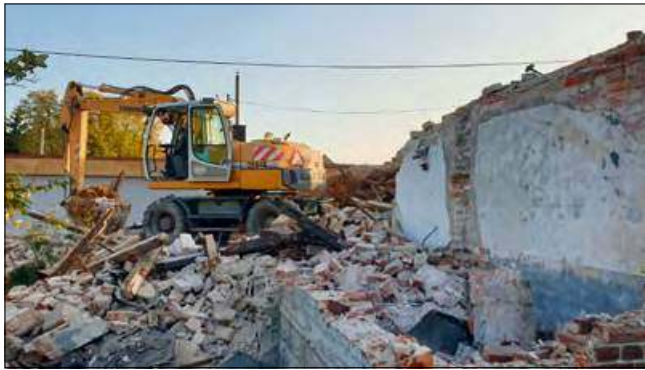
Prace rozbiórkowe ruszyły 15 października.
