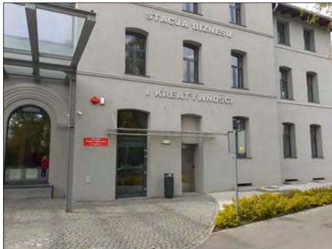
Szyld OPS już zawisł na budynku Stacji Biznesu i Kreatywności.
