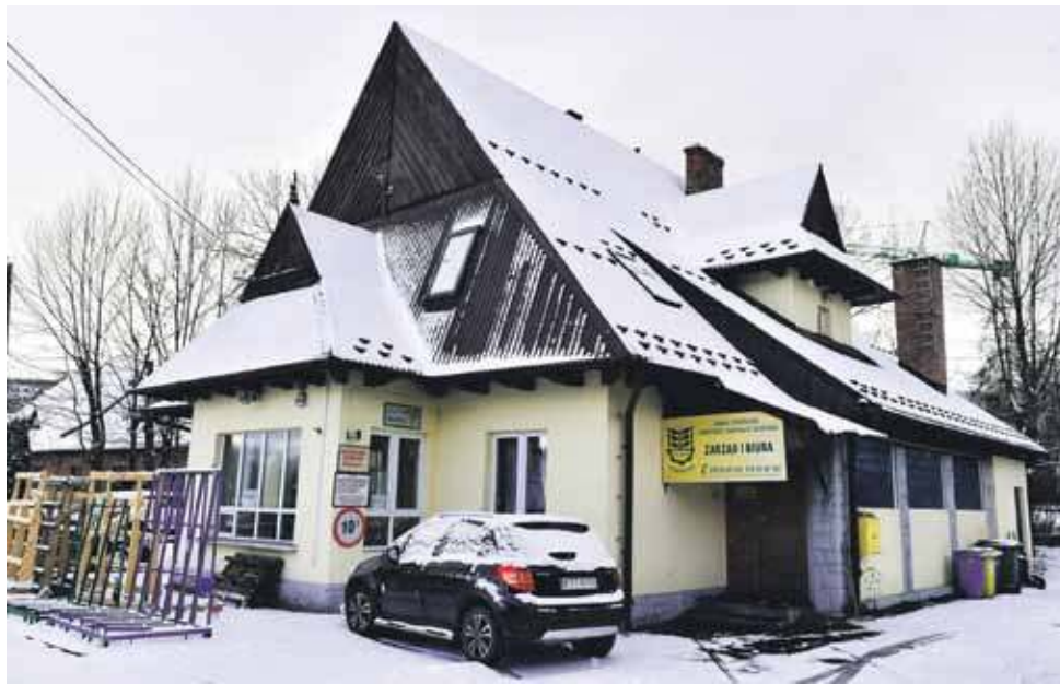
Gminna Spółdzielnia wyprzedaje swój majątek. 17 grudnia pod młotek idzie siedziba spółdzielni.
