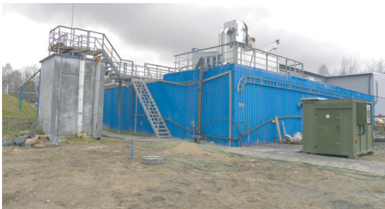
Prace budowlane przy remoncie oczyszczalni w Olszewicach już się zakończyły.
