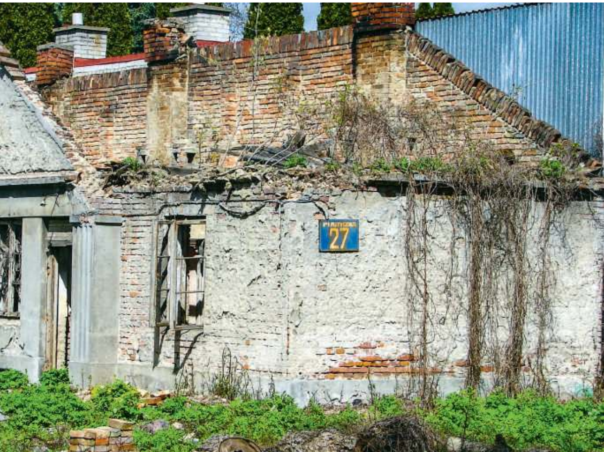
Mury domu przy ul. Plastycznej 27 we Włochach | fot. Janusz Sujecki/Gazeta Polska
