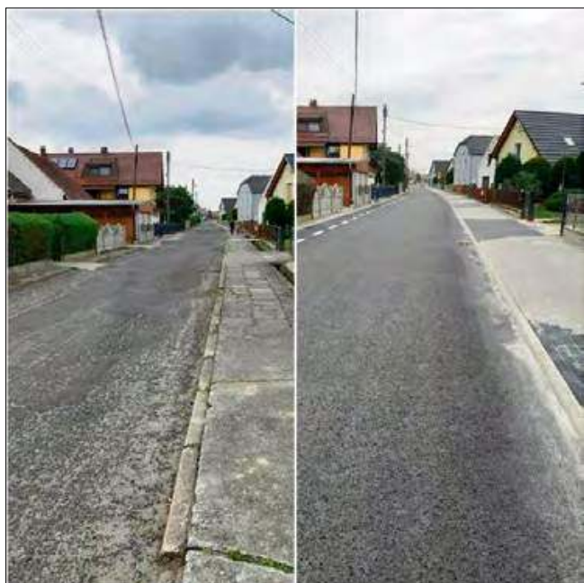
Przebudowa ulicy Granicznej w Raławiczkach. Wartość zadania to ponad milion złotych.
