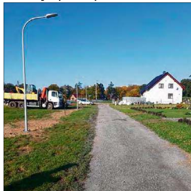
W Dobrej wybudowano oświetlenie przy ulicach Ogrodowej i Sportowej.
