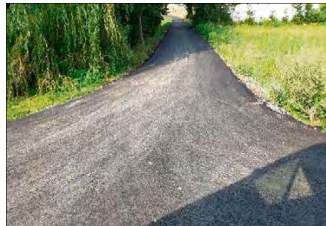
W Kujawach przeprowadzono remont łącznika ulicy Prudnickiej i Głogowskiej.
