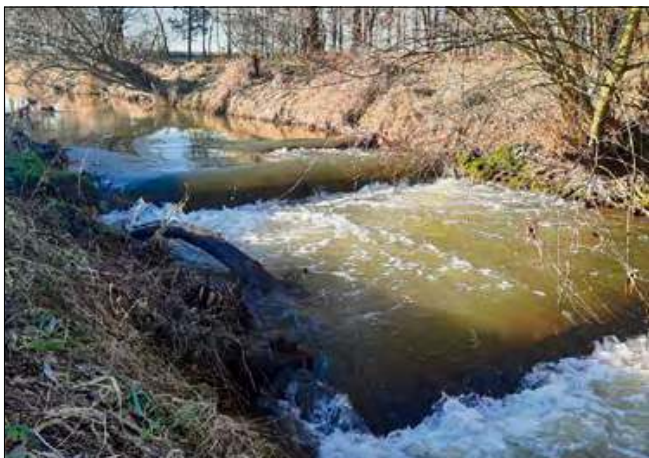
Na badanym odcinku rzeki występują trzy progi i bród.
