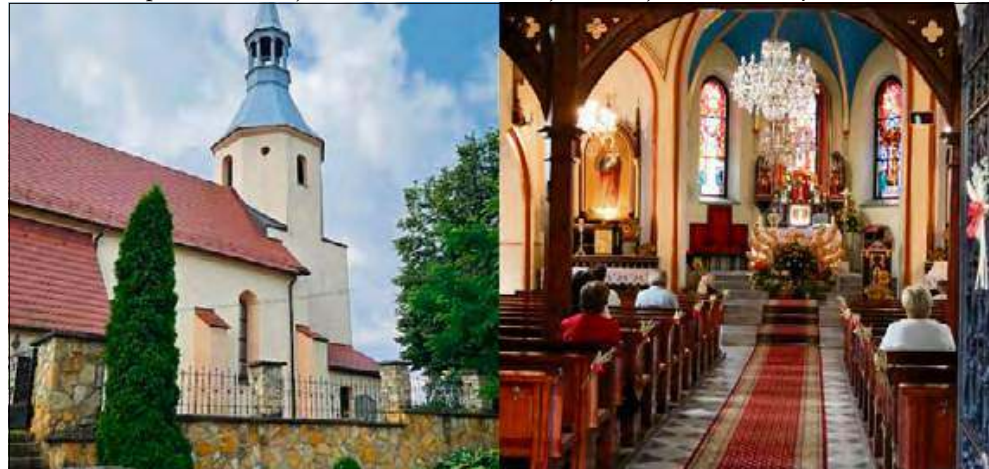
Prace renowacyjne będą prowadzone w kościołach w Pisarzowicach i Dobrej.
