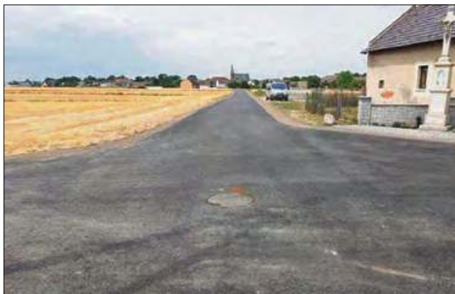
Budowa drogi wewnętrznej dojazdowej do gruntów rolnych w Komornikach. To przedsięwzięcie kosztowało ponad 160 tysięcy złotych.
