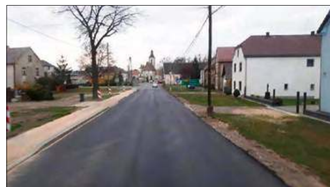
W 2019 roku przeprowadzono też modernizację odcinka drogi wojewódzkiej 409.
