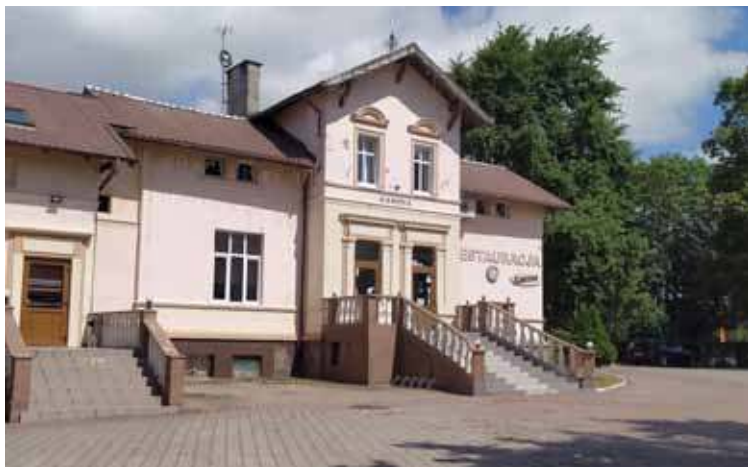
Na potrzeby powiatowej kwarantanny został zaadoptowany budynek po byłym hotelu Kamena przy ul. 3 Maja
