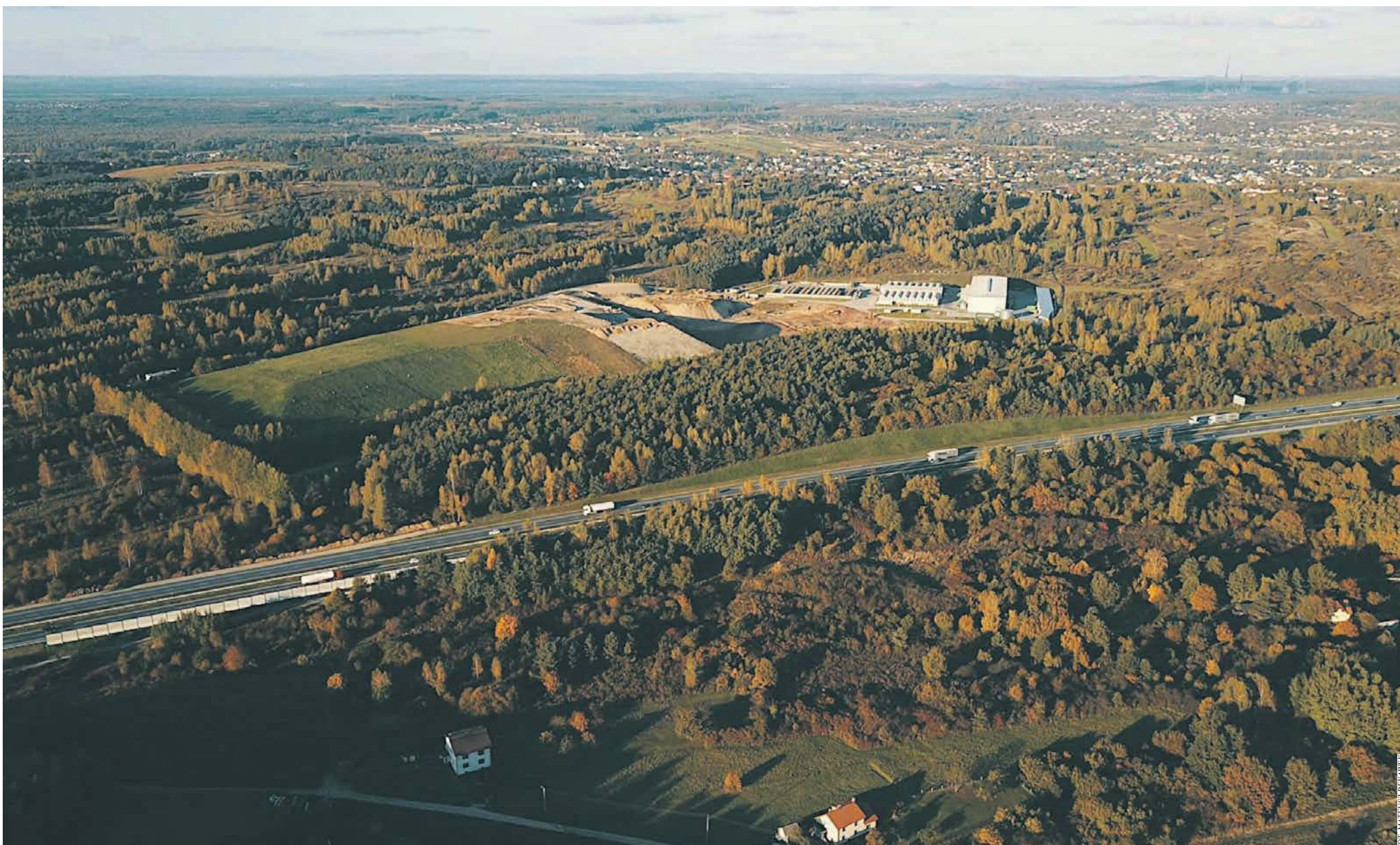
Składowisko odpadów Balinie w sąsiedztwie autostrady A4
