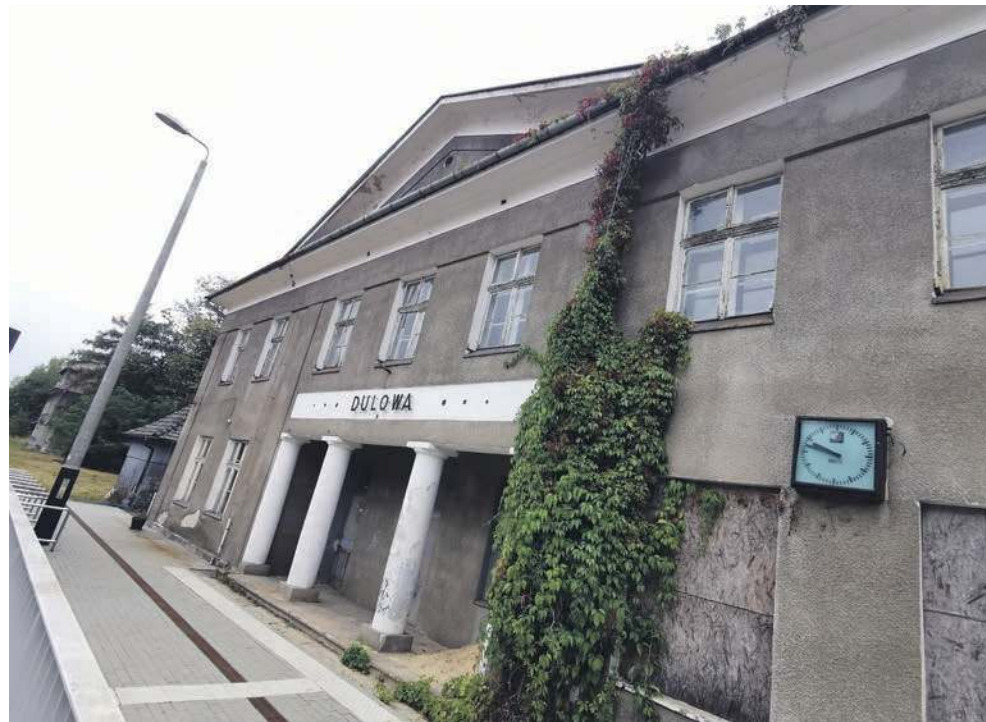
W tym budynku mieściła się kiedyś kasa biletowa i poczekalnia
