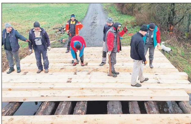
Mieszkańcy Romaszek zebrali się i wymienili nawierzchnię mostu, nie naruszając jego podstawy
