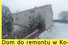
Dom do remontu w Komarnie, 604 494 489
