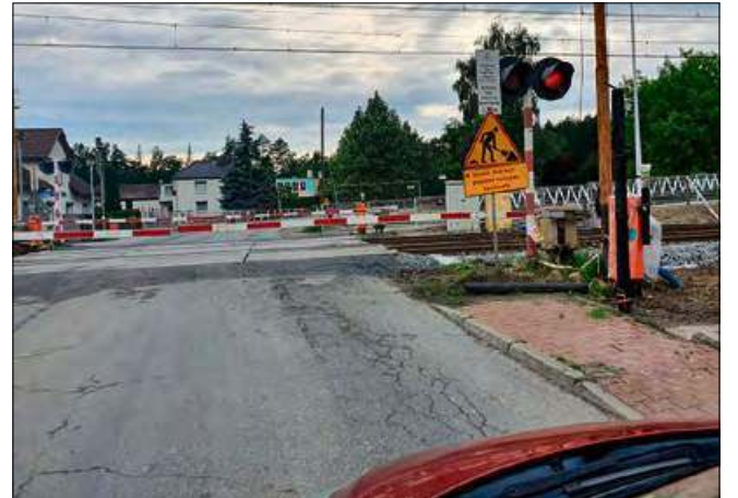
Przejazd zamknięty ze względu na prowadzone na linii kolejowej prace.
