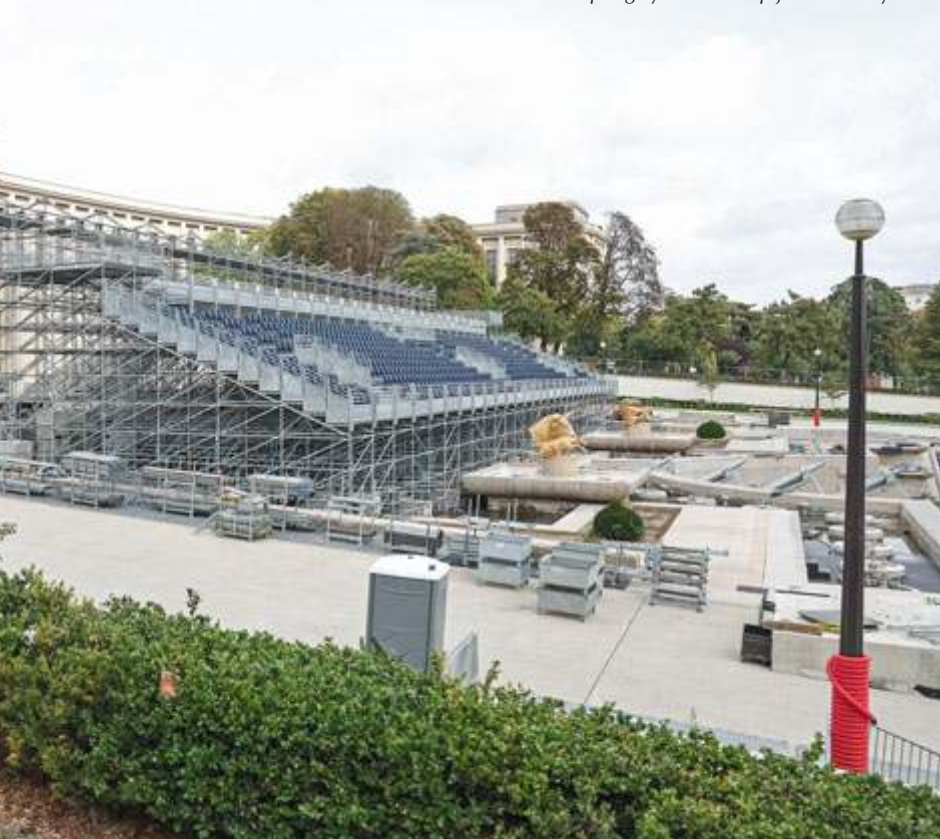
Rozbiórka stadionu Trocadero po Igrzyskach Olimpijskich w Paryżu
