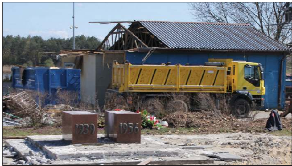
✚ Na czas budowy rozebrany został również pomnik poświęcony bohaterom Armii Krajowej. Po wybudowaniu hali zmieni on swoją lokalizację. Będzie stał bliżej ulicy Warszawskiej
