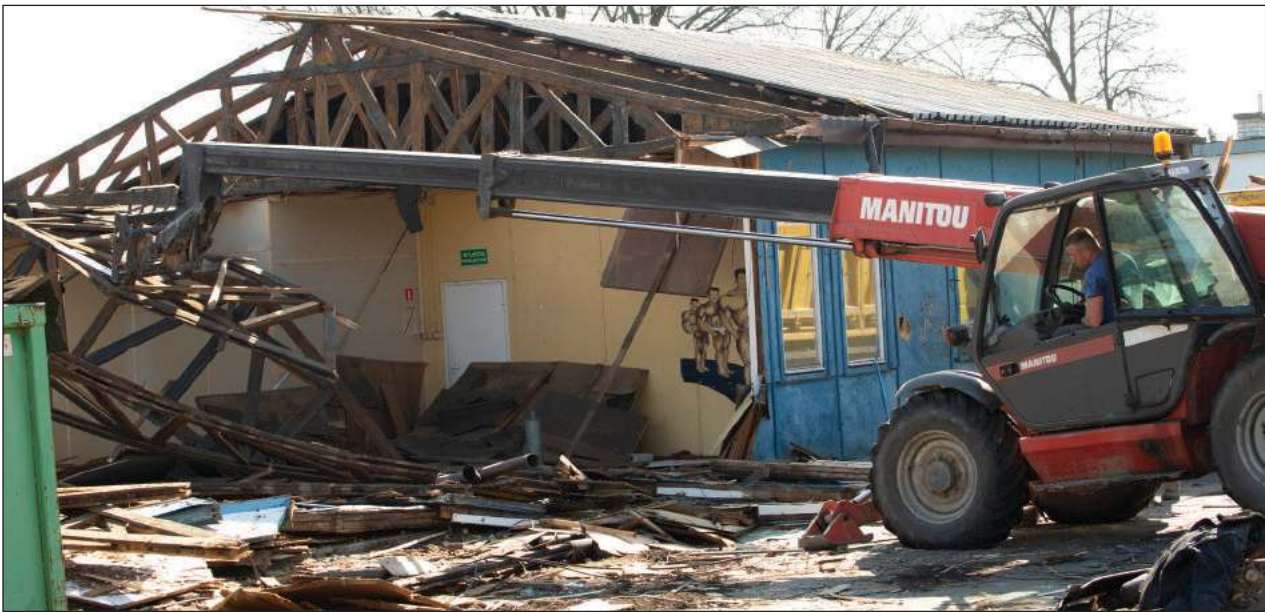
✚ W ruch poszedł cięższy sprzęt. Do wyburzenia jest stara hala sportowa. Jej fragment jeszcze stoi. Tak jak i budynki biurowe MGOSiR. Niedługo pozostaną po nich już tylko wspomnienia, tak jak po barze „Stadion”
